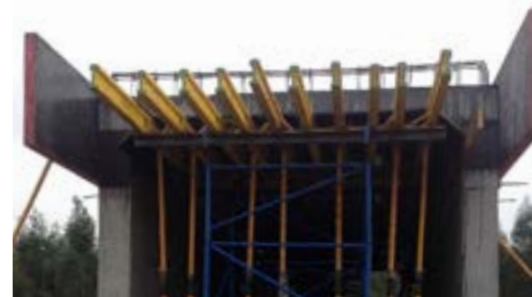
Im Einsatz: Schalungsträger von Pfeifer beim Bau des ersten Hochgeschwindigkeitszuges Afrikas
