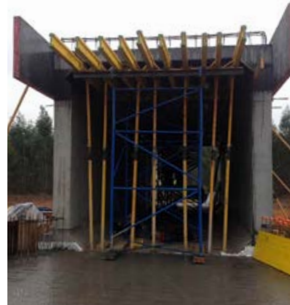
In cantiere: travi di armatura Pfeifer per la costruzione della prima linea ferroviaria ad alta velocità in Africa.
