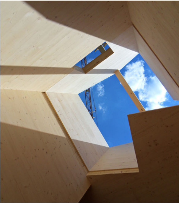
Los elementos prefabricados de CLT se emplean como paredes, forjados y tejados.
