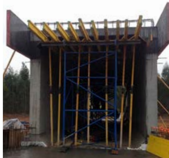
Použití: Nosiče bednění od firmy Pfeifer při stavbě první vysokorychlostní vlakové dráhy v Africe.
