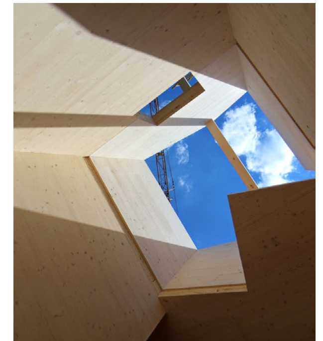
Prefabrikované CLT prvky se používají jako stěny, stropy a střechy
